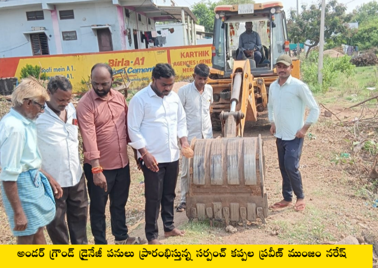
అండర్ గ్రౌండ్ డ్రైనేజీ పనులు ప్రారంభిస్తున్న సర్పంచ్ కప్పల ప్రవీణ్ ముంజం నరేష్
